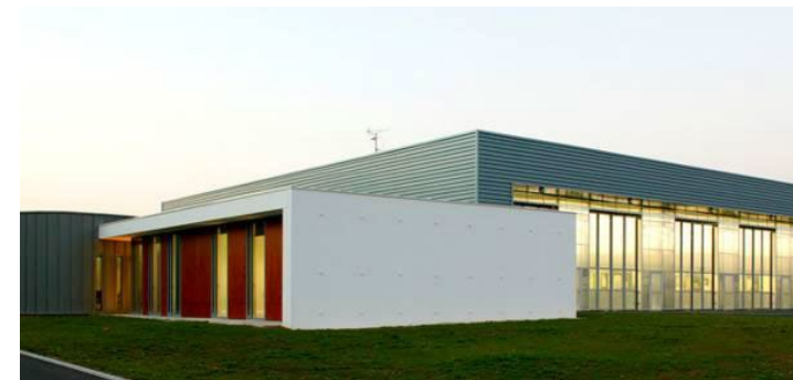
Exemple de façade bardage métallique et verre
