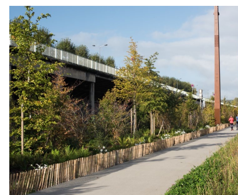
Parois végétales sur la promenade de la rivière de Rouen
