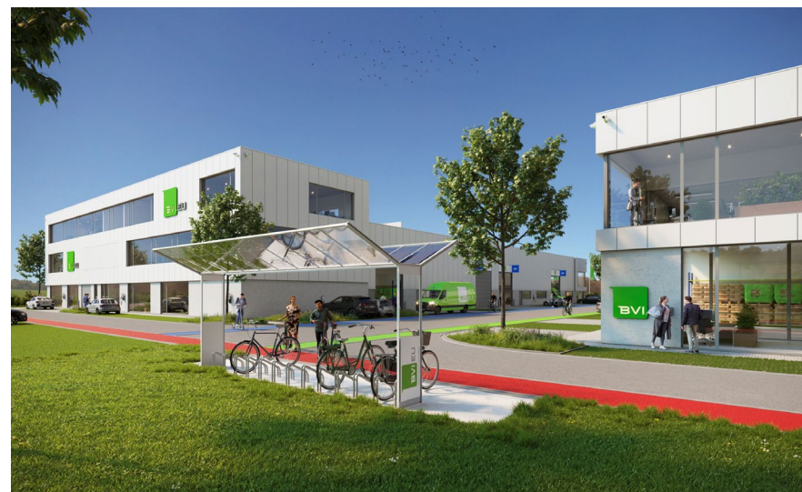
Les Six Mariannes ( parc artisanal, industriel et tertiaire )
