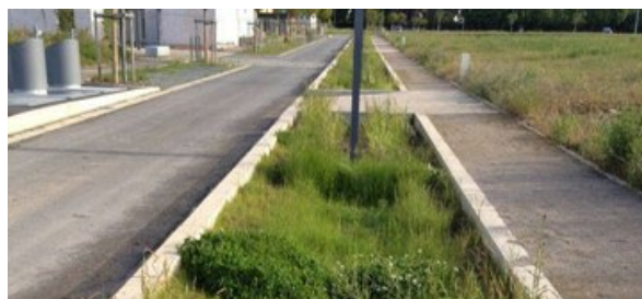
Gestion des eau grâce à des noues enherbées
