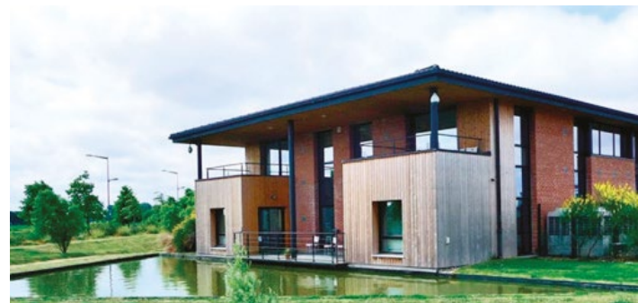
Exemple de façade en bois
