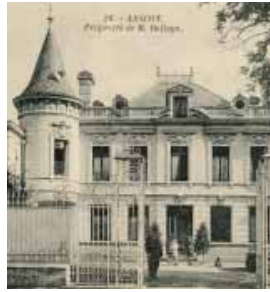
) Le château Delloye va être transformé en appartements de standing.
