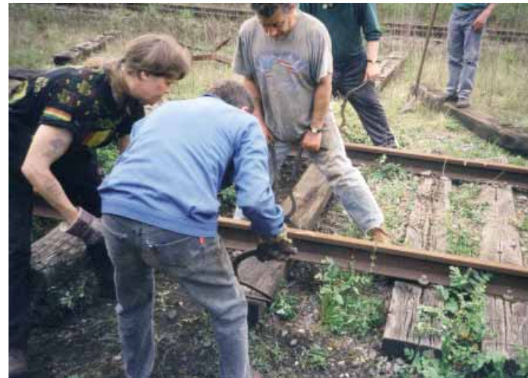
Les stagiaires ont travaillé en équipe pour poser les voies.
