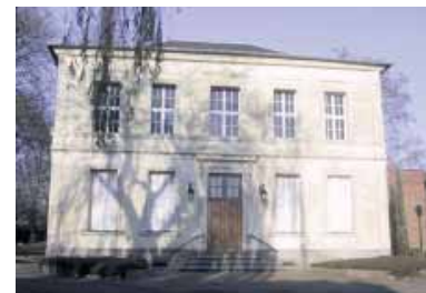
Le château de la Régie témoigne de l'essor industriel de Louches
