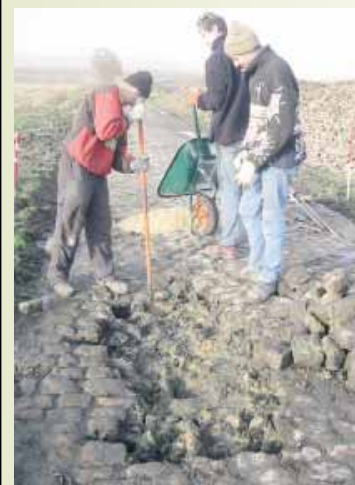
) Après les opérations de drainage et de nettoyage, il a fallu desceller les pavés.
