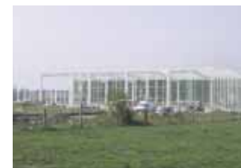
» Le centre de tri Malaquin va déployer ses activités dans un nouveau bâtiment dont l'ossature est sortie de terre en avril.
