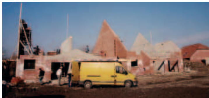
La construction de 393 logements sociaux a été financée en 2006.
